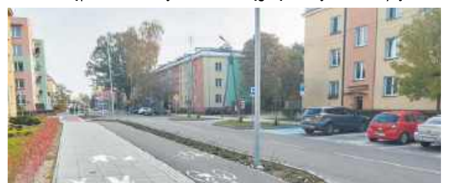
Wyremontowana ulica Kościuszki w Białej Podlaskiej
