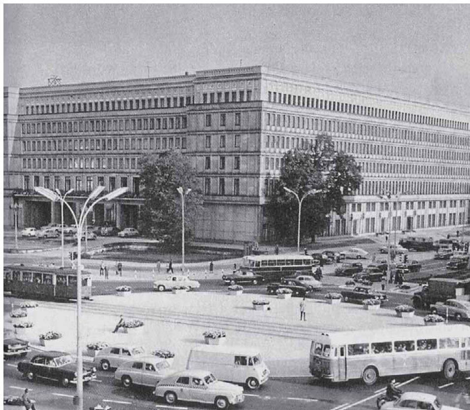
Budynek Komitetu Centralnego PZPR w Warszawie, lata 60.
