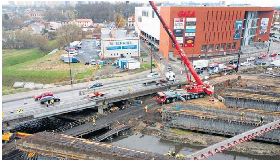
W środę rozpoczęły się prace przy układaniu wielkogabarytowych elementów nowego mostu. Dla kierowców wprowadzono zmianę organizacji ruchu
