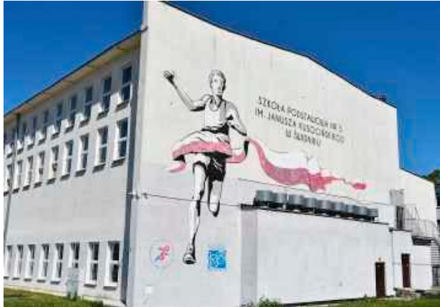
Inwestycja w „Piątce” zakłada przebudowę segmentu sportowego placówki wraz z rozbudową budynku, w którym mieści się hala sportowa
