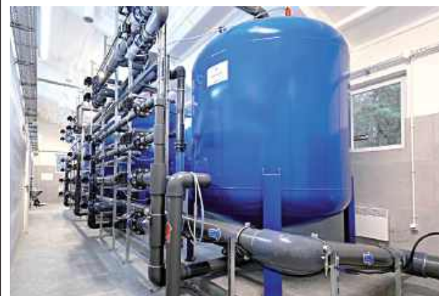
Zakres prac obejmował kompleksową przebudowę technologii uzdatniania wody
