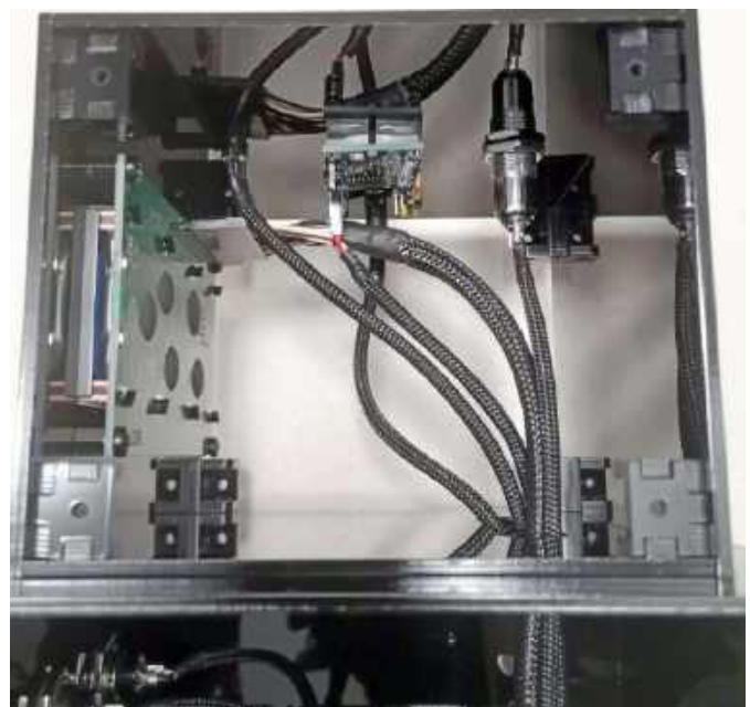
Fotografia 10. Wykonanie połączeń w górnej części obudowy
