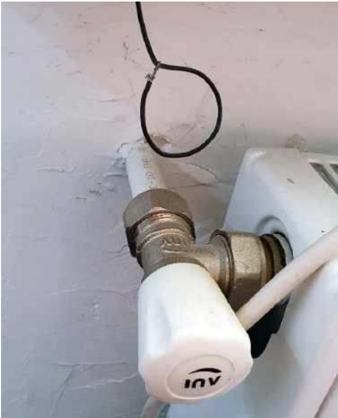
Fotografia 2. Kawłek odstąpiętego metalu skutecznie odprowadza ładunek do ziemi
