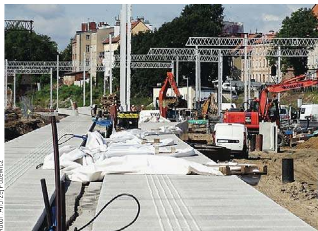
Nowa nawierzchnia na peronie 4
