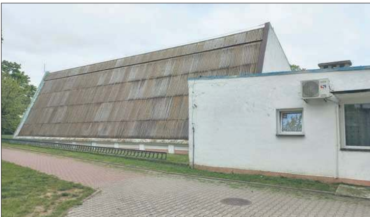
Pływalnia przy Al. Kobylińskiego zostanie wyburzona. W jej miejscu powstanie parking
