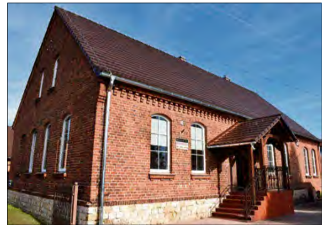
Z budżetu gminy remontowane są również wiejskie świetlice.
