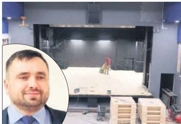
Paweł Dec: Po zakończeniu prac obie placówki mieścić się będą w dwóch nowoczesnych budynkach.
