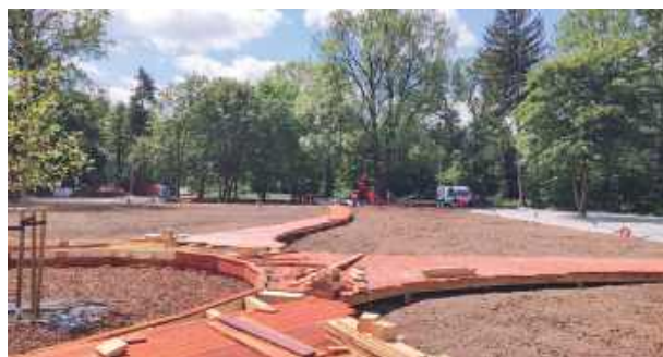
Nowe alejki to jeden z elementów zagospodarowania terenu dawnego basenu w Wiązowie. Fot. UMiG Wiązów
