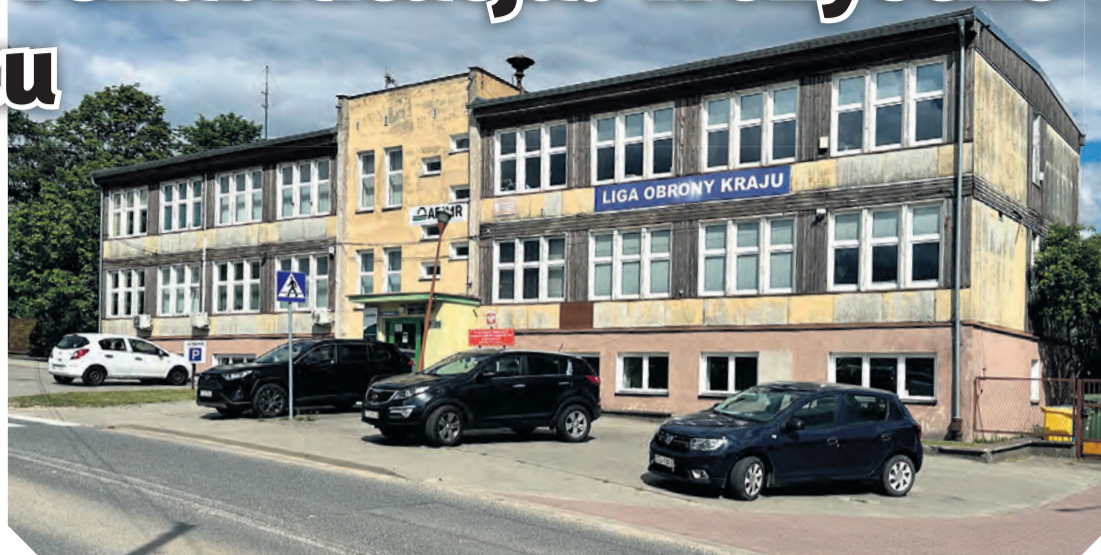
Przy ulicy Przemysłowej 2, w budynku Ligi Ochrony Kraju – w pomieszczeniach, gdzie przez lata funkcjonowały Warsztaty Terapii Zajęciowej – powstaje ośrodek rehabilitacyjno-edukacyjno-wychowawczy. Dzięki poprzedniej działalności siedziba jest już przystosowana do potrzeb przyszłych podopiecznych.
