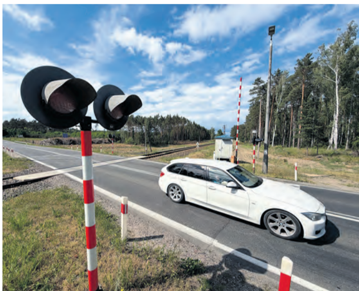
Inwestycja przewiduje przebudowę przejazdów kolejowych. To przejazd na granicy gmin Cekcyn i Lniano na drodze wojewódzkiej nr 240. Fot. (pp)
