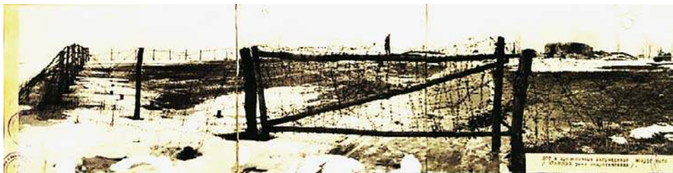
Bunkier i zasieki na dawnej polskiej przedwojennej linii obronnej w gminie Wieczfnia, 1945 r. (www.Neidenburg/Nibork/Nidzica)
