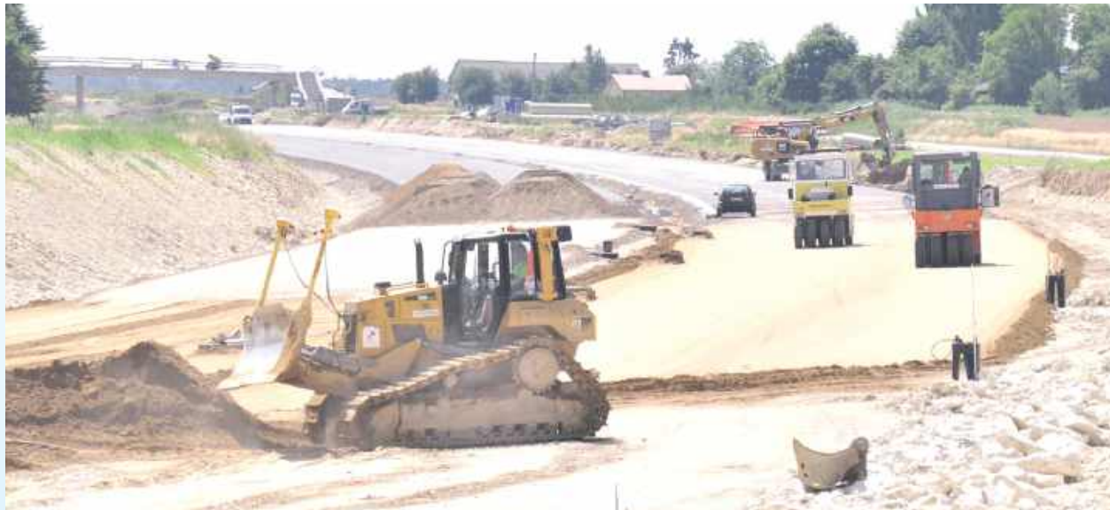
Wykonawca nowego odcinka S17 może już rozpocząć roboty budowlane
