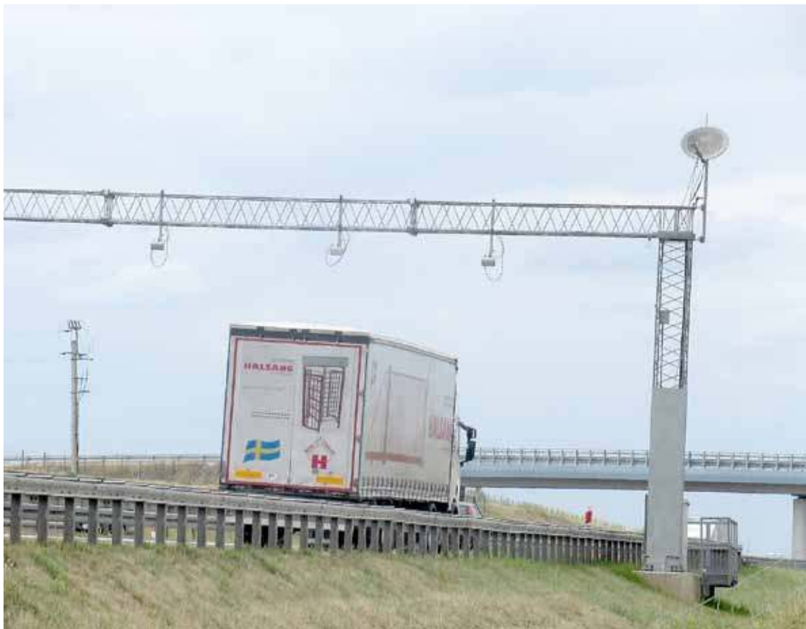
Na zdjęciu i na okładce bramka kontrolna z nadajnikiem satelitarnym na drodze ekspresowej S3, pomiędzy Gardnem i Drzeninem
