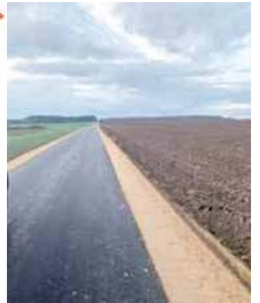
Fragment zmodernizowanej drogi Bogurzynek – Mdzewo
