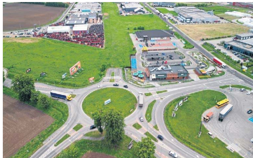
Rondo na skrzyżowaniu DK 44 z DW 781, gdzie dochodzić będzie także obwodnica zatorska w ciągu DK 28
