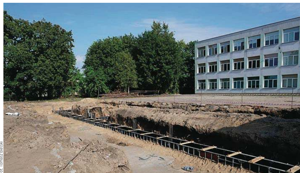
Prace przy budowie sali gimnastycznej przy Zespole Szkół nr 4 w Mławie już trwają
