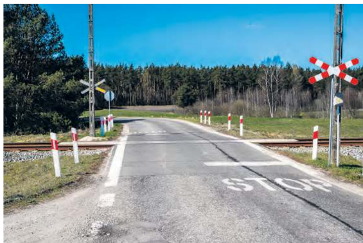
Do likwidacji przewidziano, np. przejazd w ciągu drogi powiatowej 1028C na jej odcinku pomiędzy Brzoziem a Zielonką. Fot. Arkadiusz Lorbiecki
