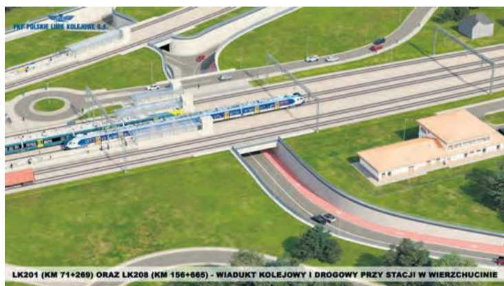
Wiadukty drogowy i kolejowe na stacji Wierzchucin. Źródło: zespół prasowy PKP Polskie Linie Kolejowe S.A.
