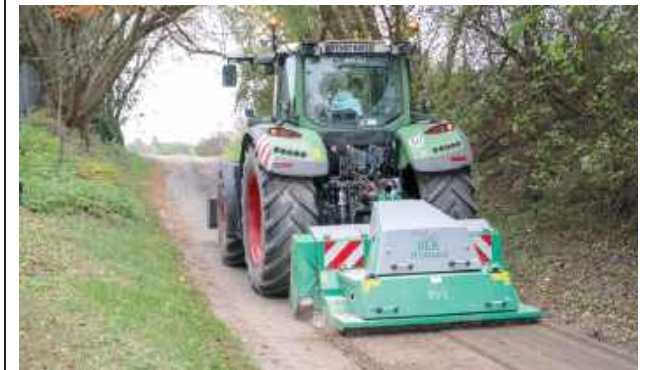
Recykler pracujący na drodze w Zakrzowie
