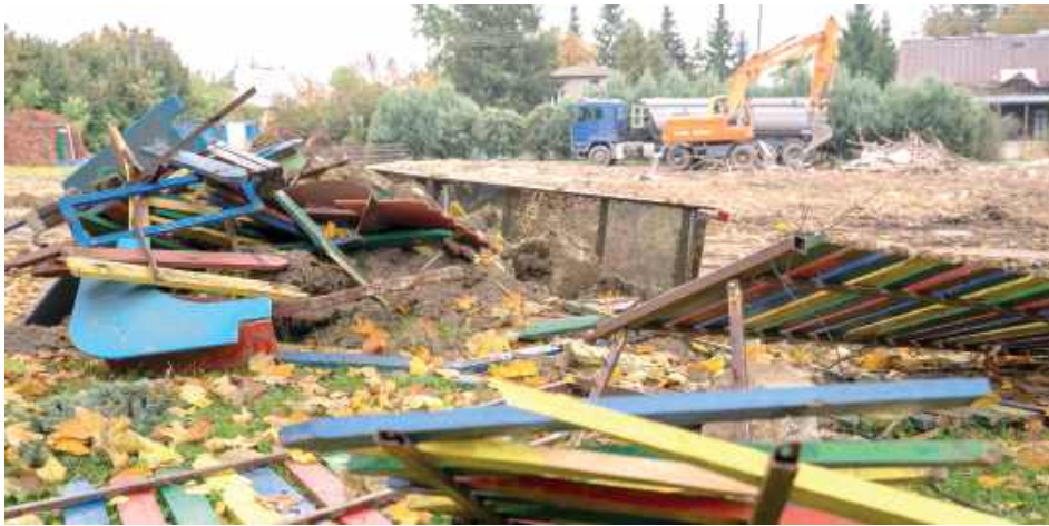
Rozbiórka przedszkola nr 1 w Łęcznej na finiszu
