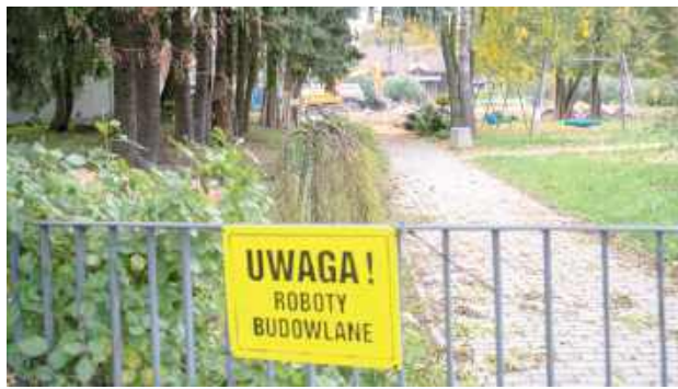
Rozbiórka przedszkola nr 1 w Łęcznej na finiszu
