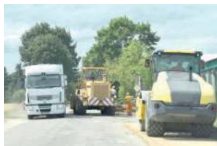
Prace wykonuje Przedsiębiorstwo Robót Drogowych S.A.
