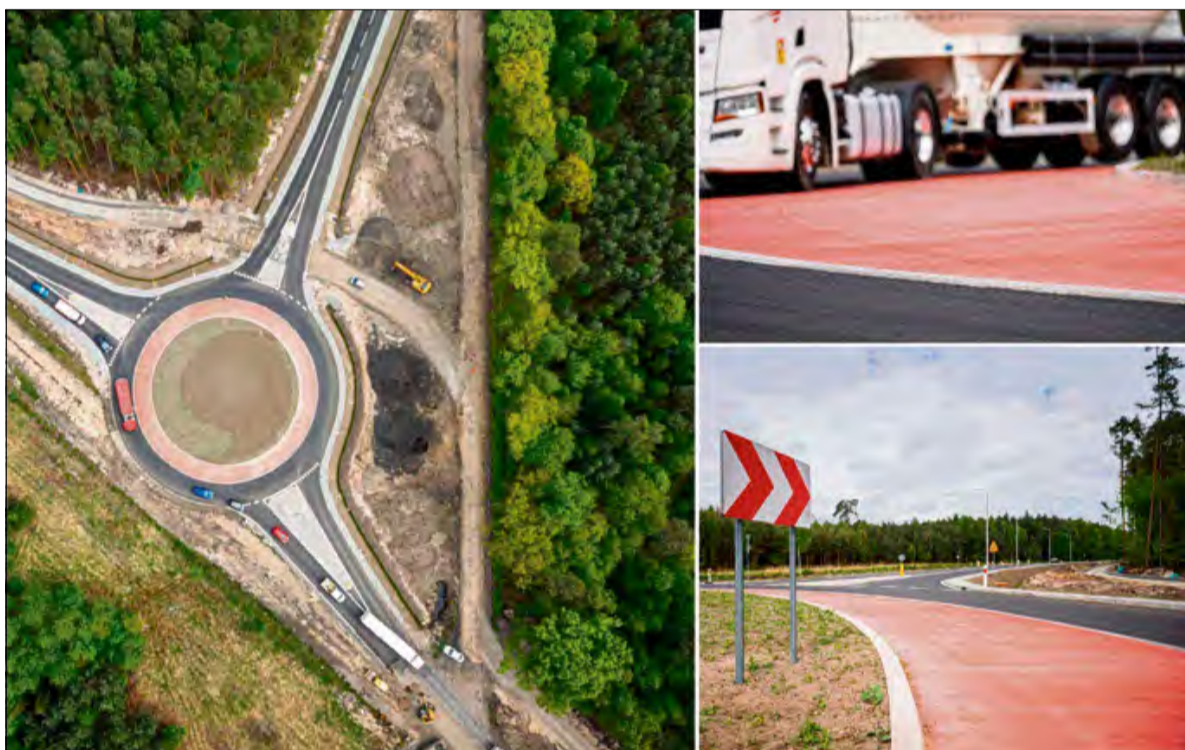
Heidelberg Materials Polska z dumą zaprezentował efekt zastosowania betonów barwionych, które nie tylko podnoszą walory estetyczne inwestycji, ale także zwiększają czytelność i bezpieczeństwo tras.
