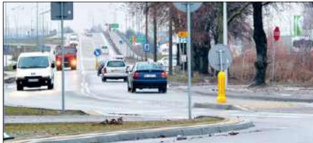
Co z pracami modernizującymi dojazd z Białej Podlaskiej do A2? Projektowanie odcinka DW 811 do węzła w Ciciборze jeszcze nie ruszyło, a projektowanie fragmentu ul. Janowskiej się wydłuża
