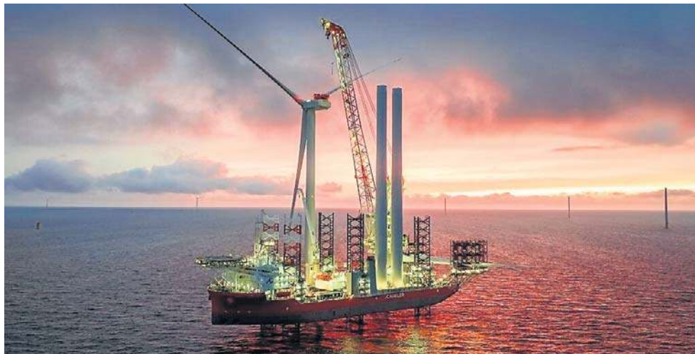
Instalacja turbin na farmie Baltic Power. Najprawdopodobniej w drugiej połowie roku popłyną z nich pierwsze dostawy energii elektrycznej.
