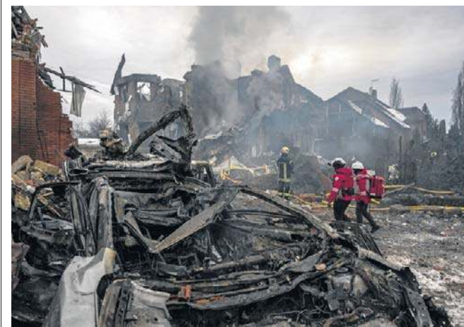
Zniszczenia po rosyjskim ataku rakietowym na mieszkalną dzielnicę Kijowa w niedzielę, 22 bm.
