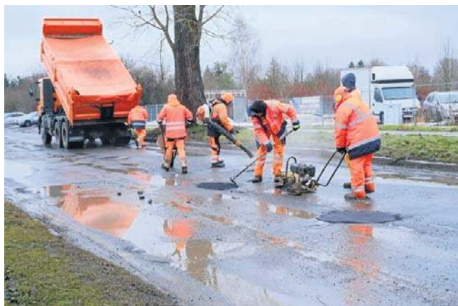
Drogowcy zalewają ubytki betonem asfaltowym na gorąco
