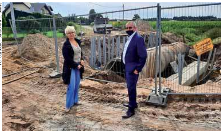
Jerzy Rzymowski wraz z Jolantą Kalkowską, kierownikiem wydziału infrastruktury Starostwa Powiatowego w Żurominie oglądali postęp prac przy budowie mostu w m. Pijawnia w gm. Siemiatkowo
