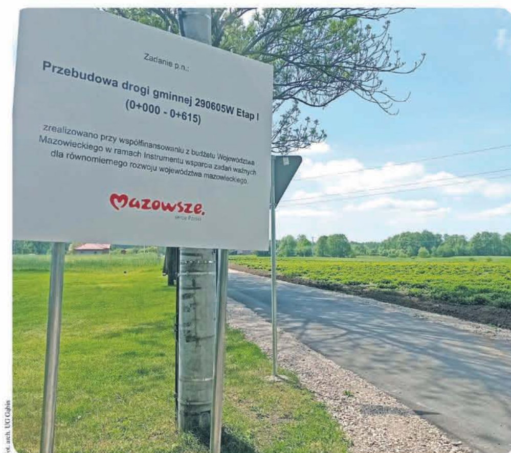
Droga gminna w gminie Gąbin została przebudowana dzięki środkom z budżetu województwa mazowieckiego
