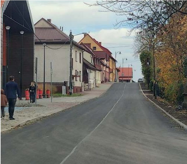
Wyremontowana ul. Korycińskiego w Alwerni
