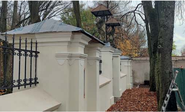
Remont fragmentu muru otaczającego klasztor w Alwerni
