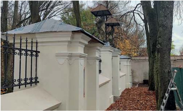
Remont fragmentu muru otaczającego klasztor w Alwerni
