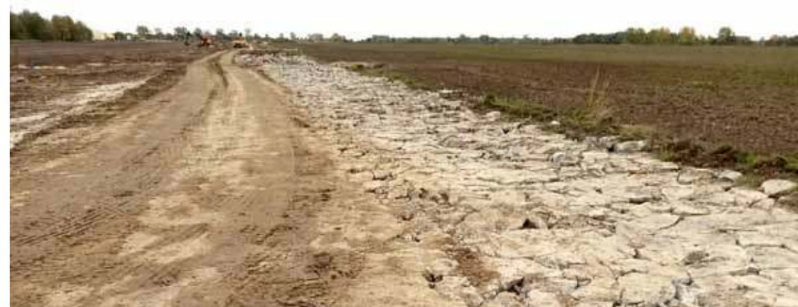
Obecnie w tym miejscu trwa kruszenie płyt betonowych.
