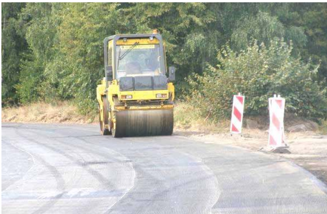
W ramach prac przygotowawczych przesunięto ogrodzenia prywatnych posesji, wytyczono nowy chodnik i ścieżkę rowerową.
