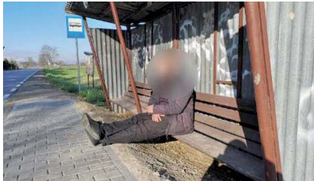
Wykonawcą montażu przystanku przy drodze powiatowej w Stoczku było PRD w Lubartowie. Na pytanie redakcji, czy firma na własny koszt przewiduje naprawienie „błędu w sztuce”, każe czekać. Kierownik jest na urlopie
