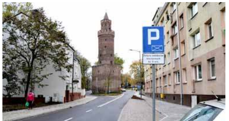
Na ulicy Krzywoustego wymieniono nawierzchnię jezdni, ułożono nowe chodniki, wydzielono zatoczkę dla autokarów
