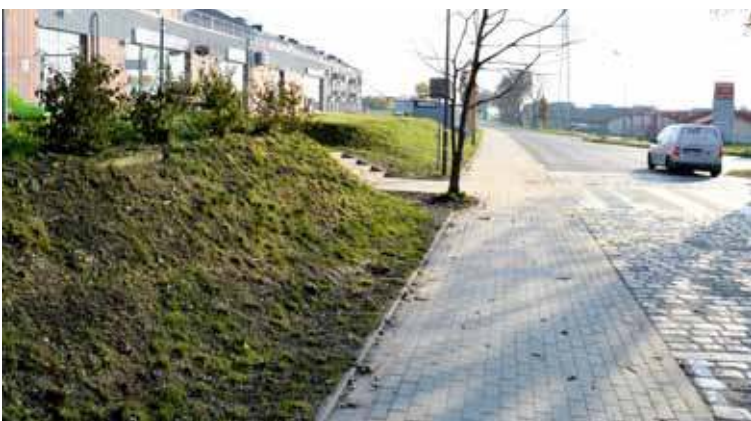
Nowy chodnik biegnie na odcinku od skrzyżowania ul. Niepodległości z ul. Powstańców Warszawy - do granic miasta
