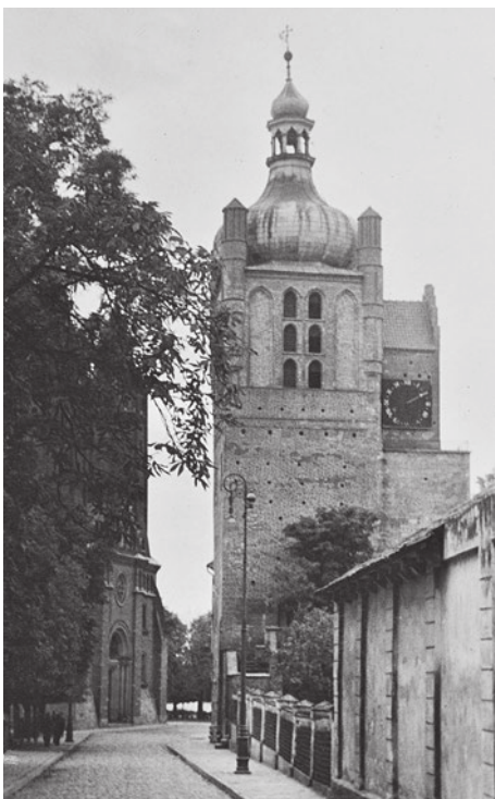
Dzwonnica katedralna w Płocku wraz z przylegającą do niej wieżą zegarową
