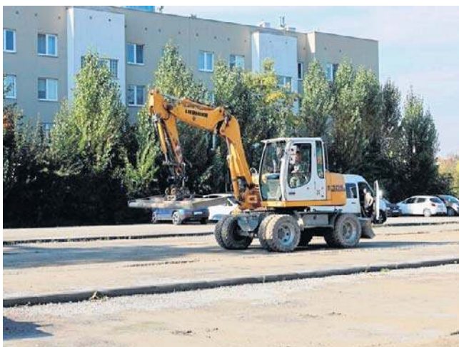
W środę na parkingu przy ul. Warzywnej trwały prace remontowe. Teren był równany i utwardzany kruszywem
