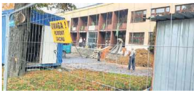
Prace już trwają, ale póki co wejście główne do budynku jest otwarte.
