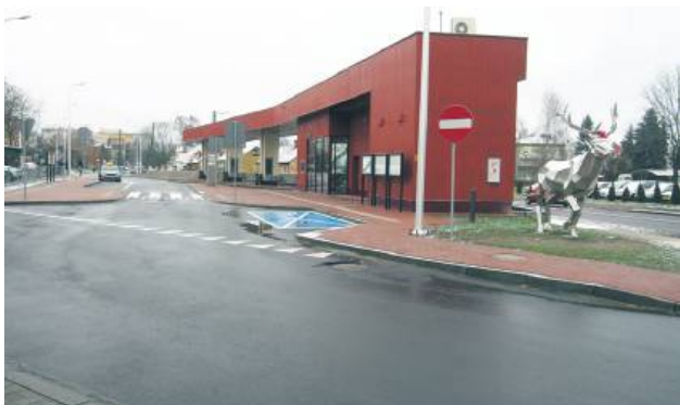
Budowa HCK kosztowała ponad 5 mln zł.
