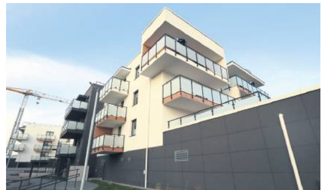
Przy ul. Królowej Jadwigi jeden z zamojskich deweloperów wybudował dwa czterokondygnacyjne bloki, w których jest łącznie 107 mieszkań.
