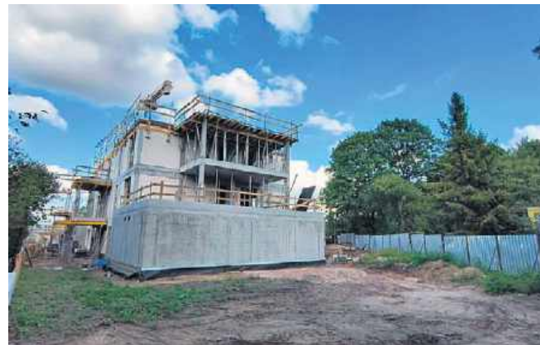
Największe zmiany widać w części przeznaczonej pod bloki. W jednym z budynków zakończono już trzecią kondygnację
