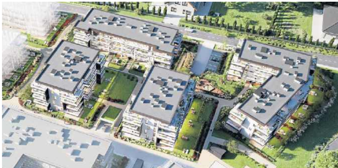
Wiosną bieżącego roku rozpoczęła się budowa przedostatniego – VI etapu osiedla Bella Vista
