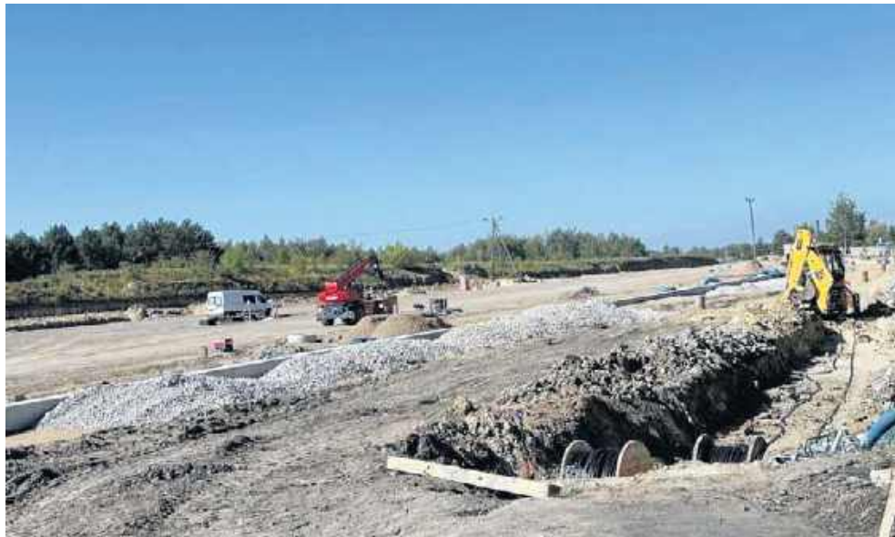
Przy ulicy Energetyków w radomiu trwa budowa terminala przeładunkowego.
