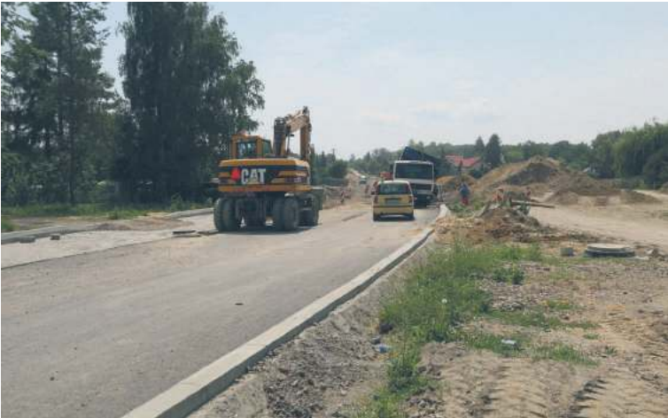
Jeśli budowa ul. Kusocińskiego będzie przebiegała w dotychczasowym tempie, inwestycja zostanie ukończona przed czasem
