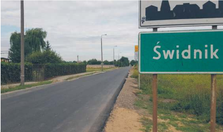
Ulica Krępiecka z nowym asfaltem. Po ziemnych wykopach nie ma nawet śladu
