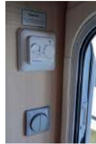
Sterowanie podłogowymi foliami grzewczymi znajduje się przy drzwiach wejściowych
