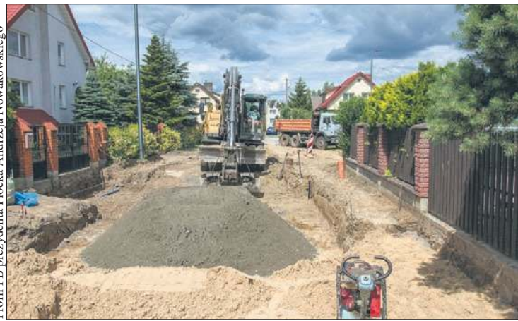
Prace na ulicy Herbacianej są zaawansowane na tyle, że może ona być gotowa do końca wakacji
