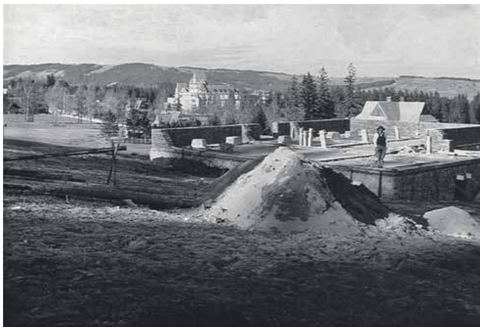
Budowa kaplicy i ochronki na Jaszczurówce, 1935 r.
