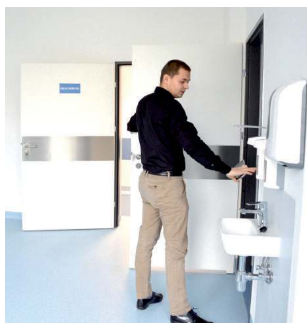
Każda sala chorych wyposażona jest w instalację tlenową, której do tej pory nie było i łazienkę
