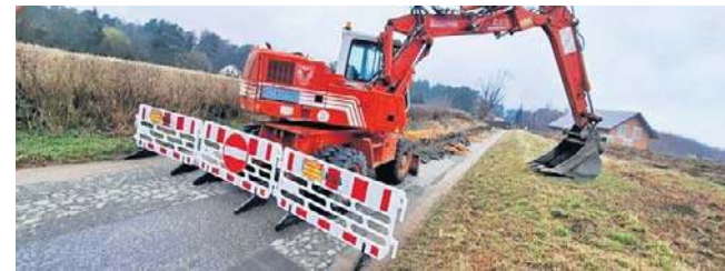
Utrudnienia są spowodowane rozpoczętą tu budową kanalizacji
