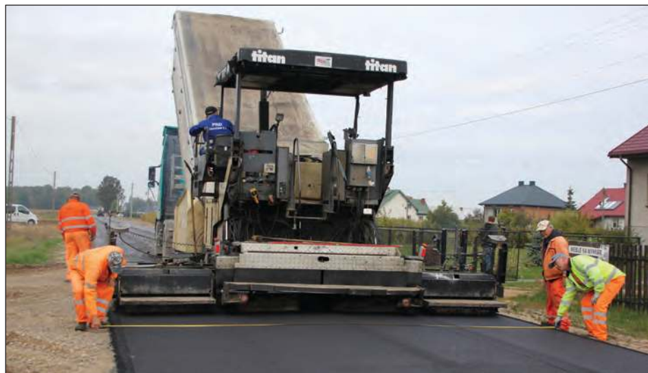
W piątek rozpoczęło się układanie ostatniej warstwy asfaltu na drodze
