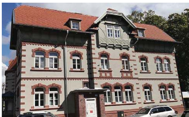
Budynek przychodni zdrowia, w którym dokonano remontu sieci wewnętrznych
