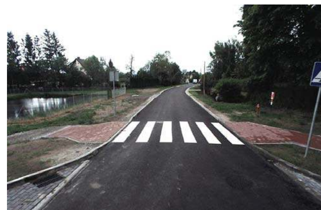
Pilon: wyremontowany odcinek drogi gminnej
