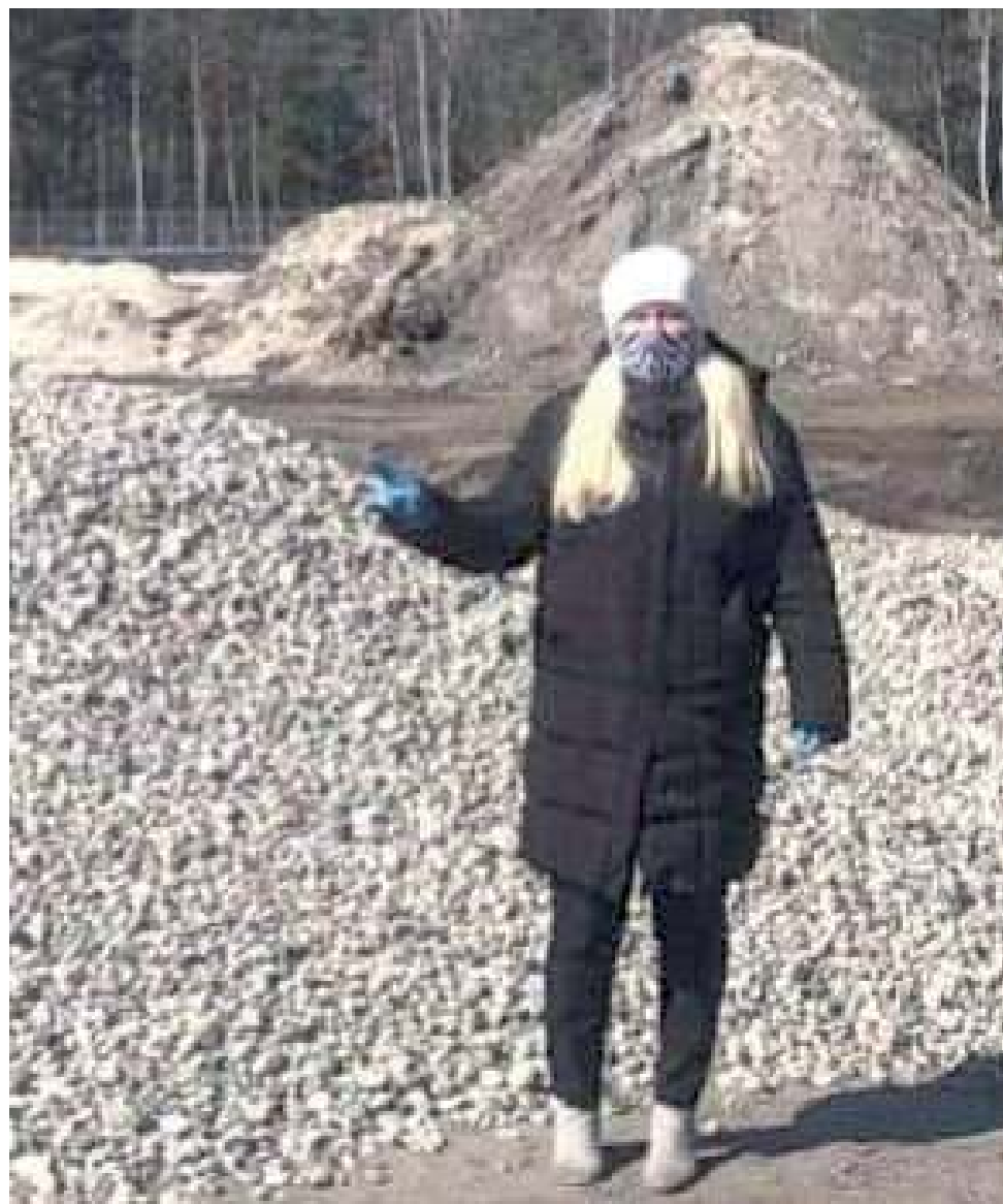
Wójt Grażyna Lamczyk z wizytacją na niedokończoną oczyszczalnię ścieków w Białce
