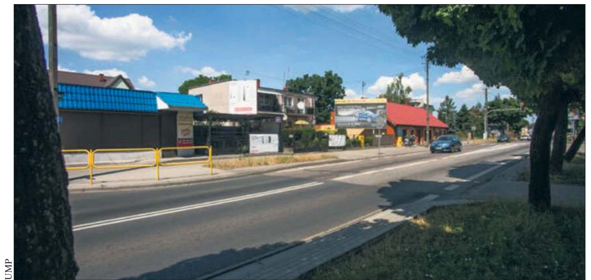
Przebudowa ulicy Kolejowej zakończy się przy skrzyżowaniu z ulicą Zieloną
