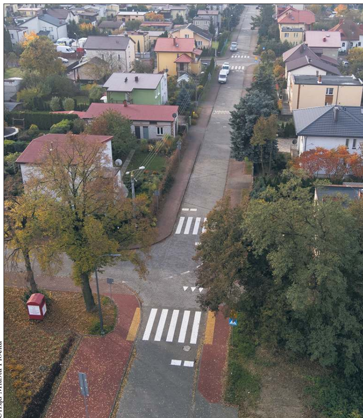
Ulica Kątowa po trwającej od stycznia tego roku przebudowie
