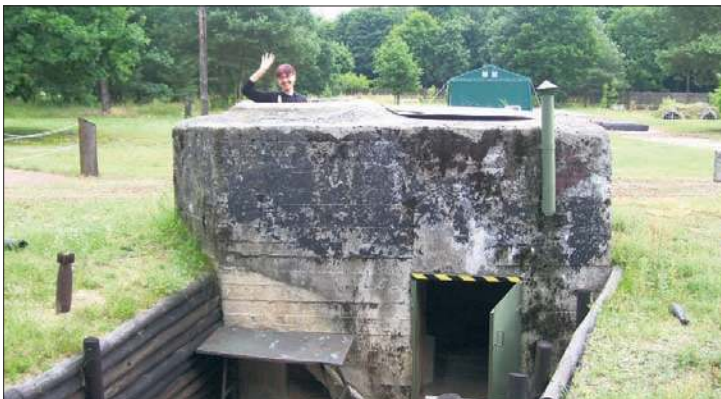
Skansen rzeki Pilicy. Żelbetonowy schron stanowiący w 1944 roku system niemieckich umocnień na rzece, przeniesiony na teren skansenu spod Sulejowa
