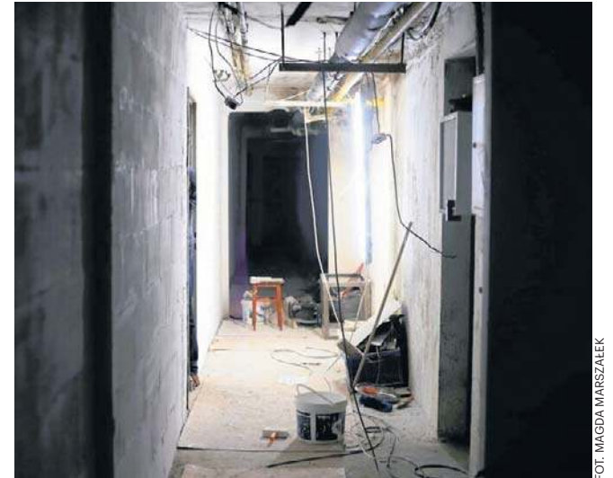
W piwnicach trwają ostatnie roboty wykończeniowe
