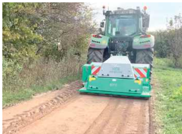
Dzięki temu urządzeniu w szybki sposób można remontować drogi gruntowe
