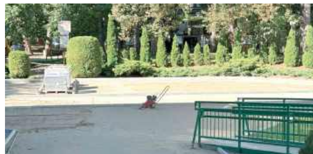
Teraz przy wejściu do szkoły zostanie poprawiony wjazd, a także powstanie nowy parking. Obecnie prace na terenie SP nr 6 nie zostały jeszcze zakończone
