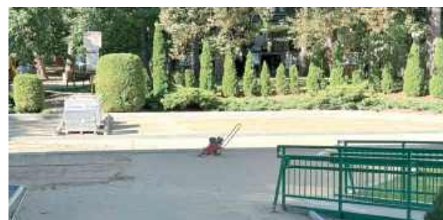
Teraz przy wejściu do szkoły zostanie poprawiony wjazd, a także powstanie nowy parking. Obecnie prace na terenie SP nr 6 nie zostały jeszcze zakończone
