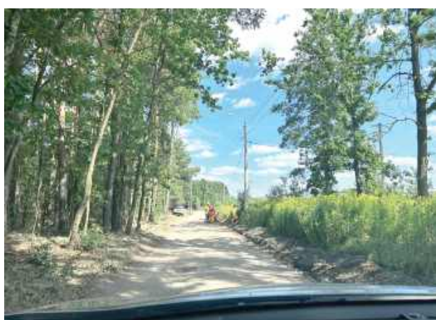
Trwają prace budowlane na ulicy Polnej w Trąbkach
