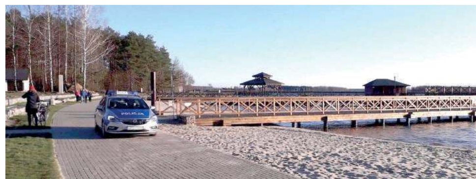
Policja przyjechała i zwracała uwagę ludziom, że wstęp na teren zalewu jest zabroniony, bo to plac budowy
