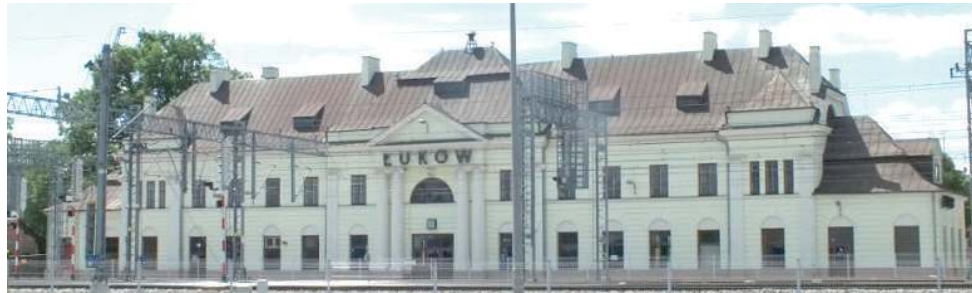
W budynku dworca PKP powstanie nowoczesna sala widowiskowa. Za remont i wyposażenie zapłaci spółka PKP
